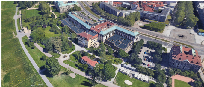
Bildunterschrift: Die Solaranlage wird Anfang 2023 auf zwei Dächern des Bilderberg Bellevue Hotel Dresden installiert.
